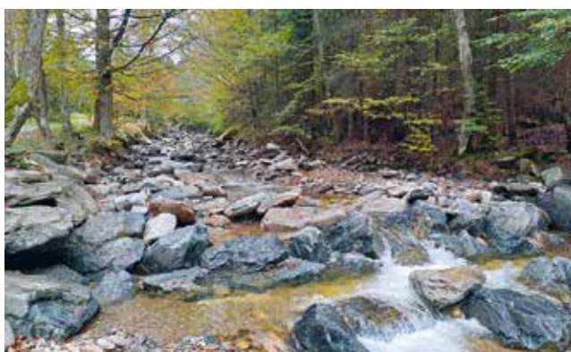
Hučivá Desná – Loučná nad Desnou – Kouty, stabilizační funkce příčných balvanitých objektů.
