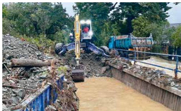
Valštejnský potok – Město Albrechtice, zabezpečovací práce na zprůtočnění koryta.
