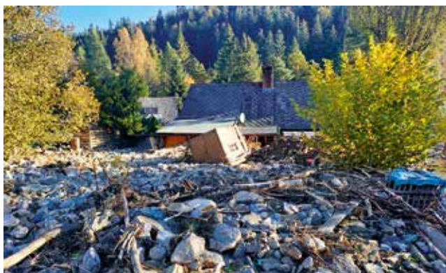
Suchý potok – Mnichov, splaveniny transportované do zástavby.
