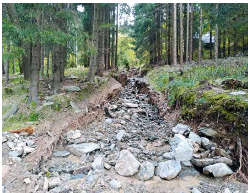
Povodí Suchého potoka – Mnichov, eroze svážnice.
