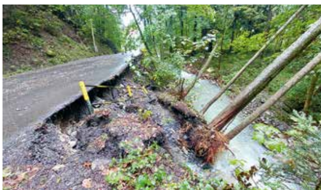
Sepetný potok – Ostravice, vlevo poškození lesní komunikace, vpravo zabezpečovací práce na zpřístupnění území a stabilizaci koryt.
