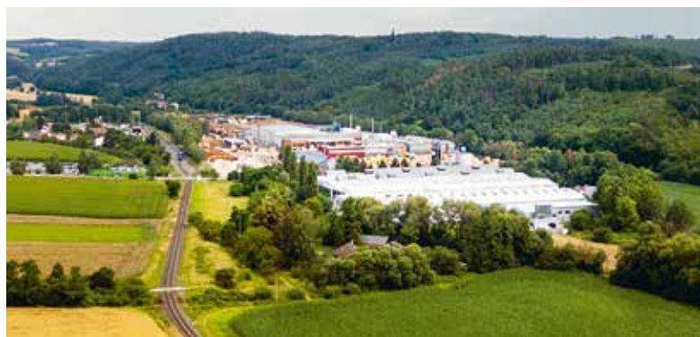
Výrobní areál NOVATOP v Ptení.
