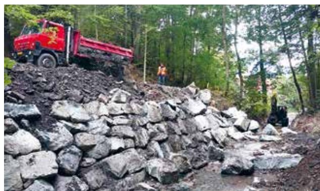
Sepetný potok – Ostravice, vlevo poškození lesní komunikace, vpravo zabezpečovací práce na zpřístupnění území a stabilizaci koryt.
