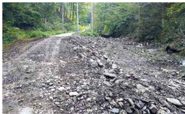
Mazák – Ostravice, vlevo nádrž v komunikaci, vpravo stav po provedení zabezpečovacích prací na zpřístupnění území a stabilizaci koryt.
