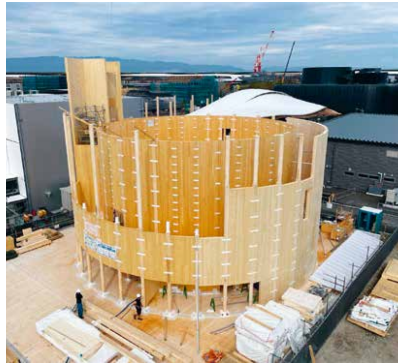
Montáž českého pavilonu na EXPO 2025.
