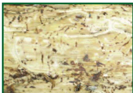
Rozvinuté pozerky lýkožrouta menšího obtištěné v dřevě.
